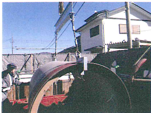
■写真3 新設管投入状況
