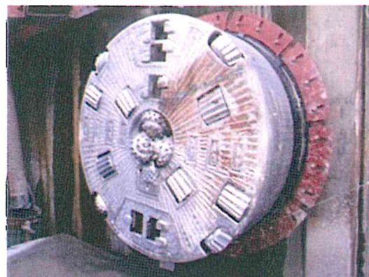
■写真5 掘進機到達状況
