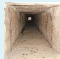
既設石積暗渠
