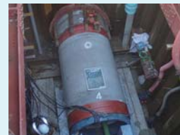
改築推進施工状況
