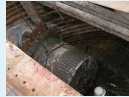
掘進機到達状況
