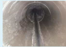
新設管内状況
