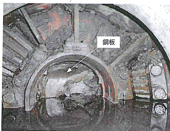
写真-6 点検扉より確認状況
