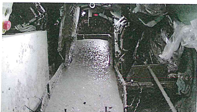
写真-4 機内排土状況
