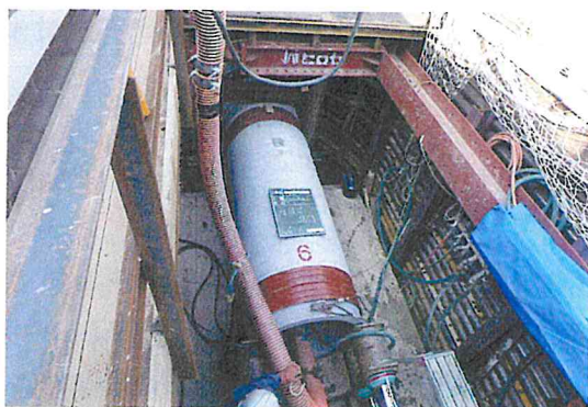
写真－4 CMT改築推進状況
