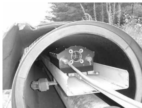
写真 2.4-2 管内配置状況
